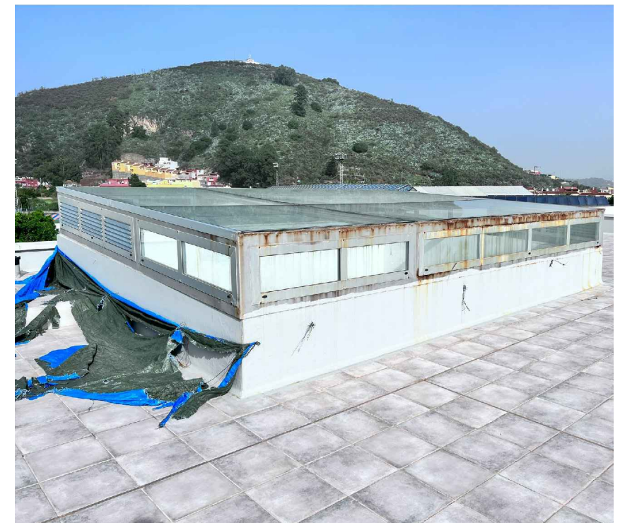
FOTOGRAFÍA CUBIERTA E. ACTUAL
